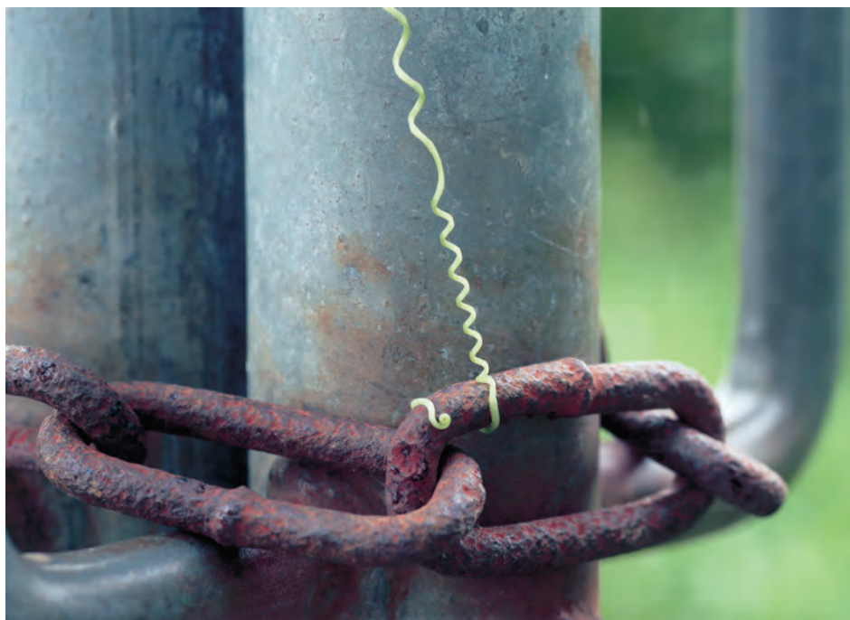
補強 Reinforcement 野村 成次 Nomura Seiji
